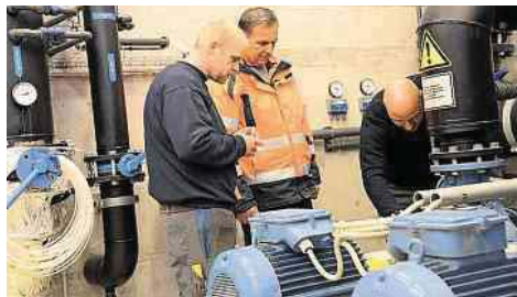
Bademeister Vuko Ratkovic (Mitte) und die Bafilco-Monteure Dominik Breiter (links) und Nicola Di Marco setzen die Anlage in Betrieb.
